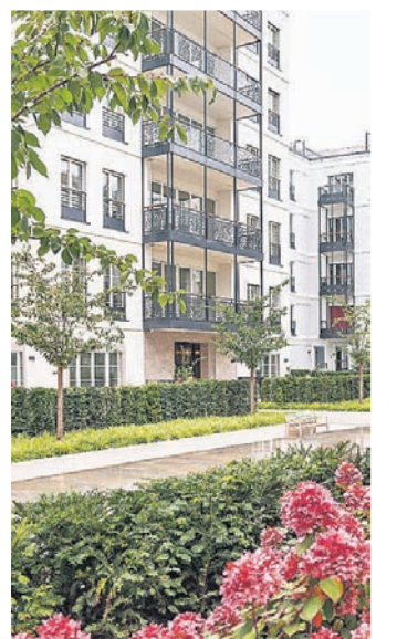
Ein Blick auf die Balkone zum Innenhof des Andreas Quartiers.
