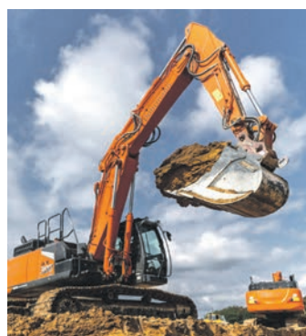
GPS-gesteuerter Bagger im Einsatz
