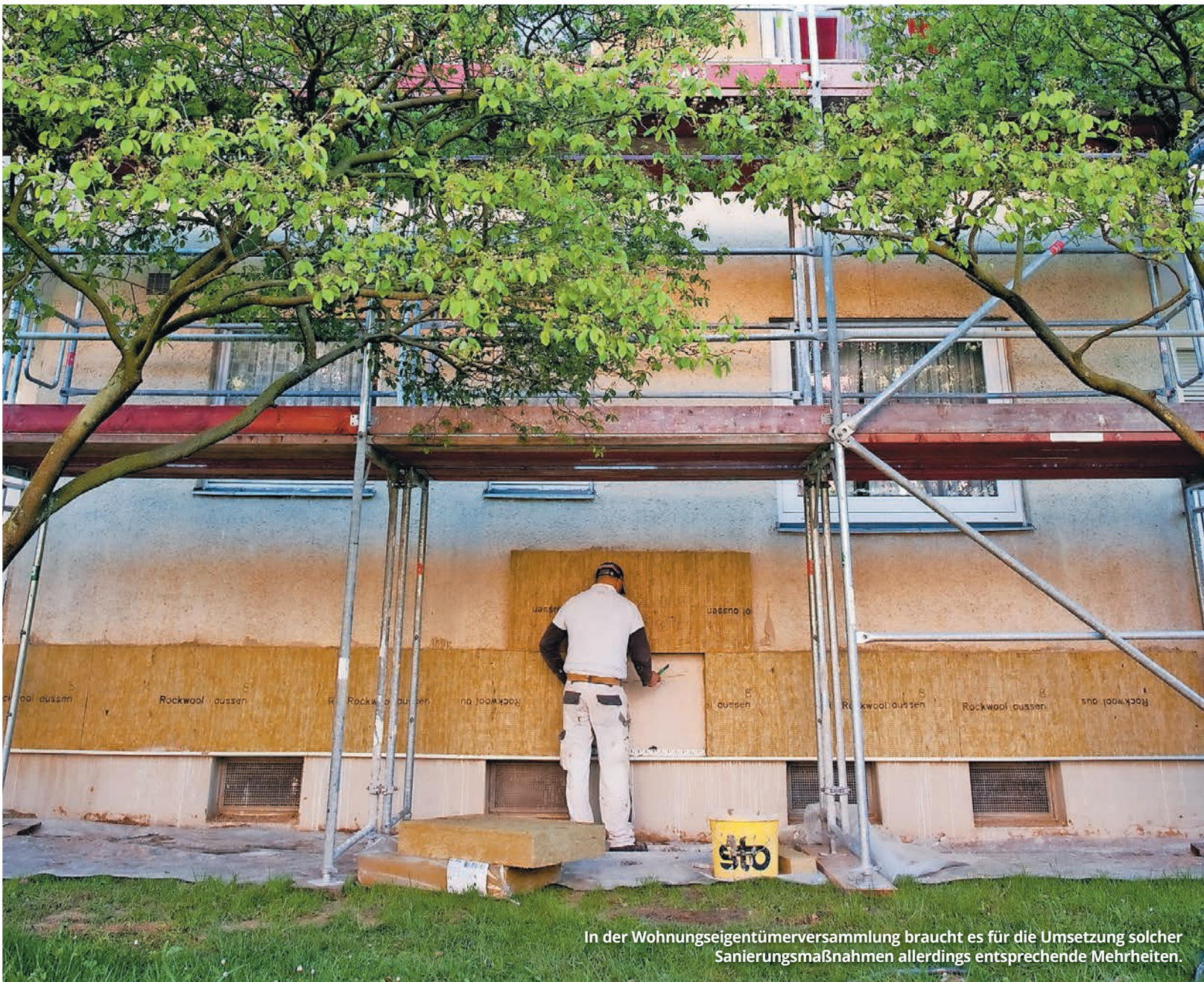
Die Mängelbeseitigung, etwa von Bruchstellen im Putz, kann ein Anlass für die energetische Sanierung sein.
