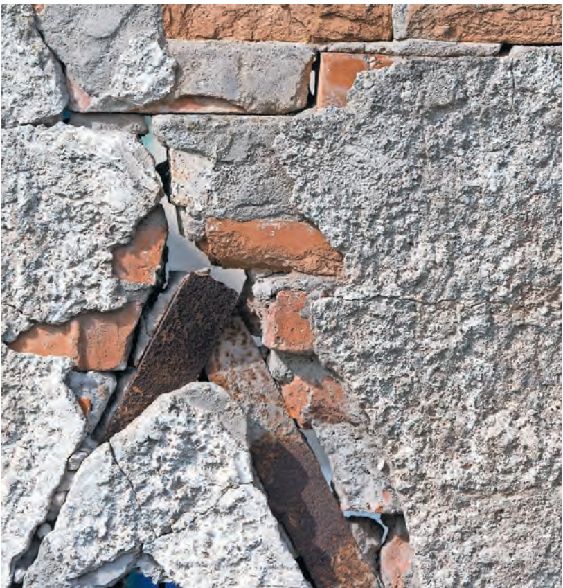
Die Mängelbeseitigung, etwa von Bruchstellen im Putz, kann ein Anlass für die energetische Sanierung sein.
