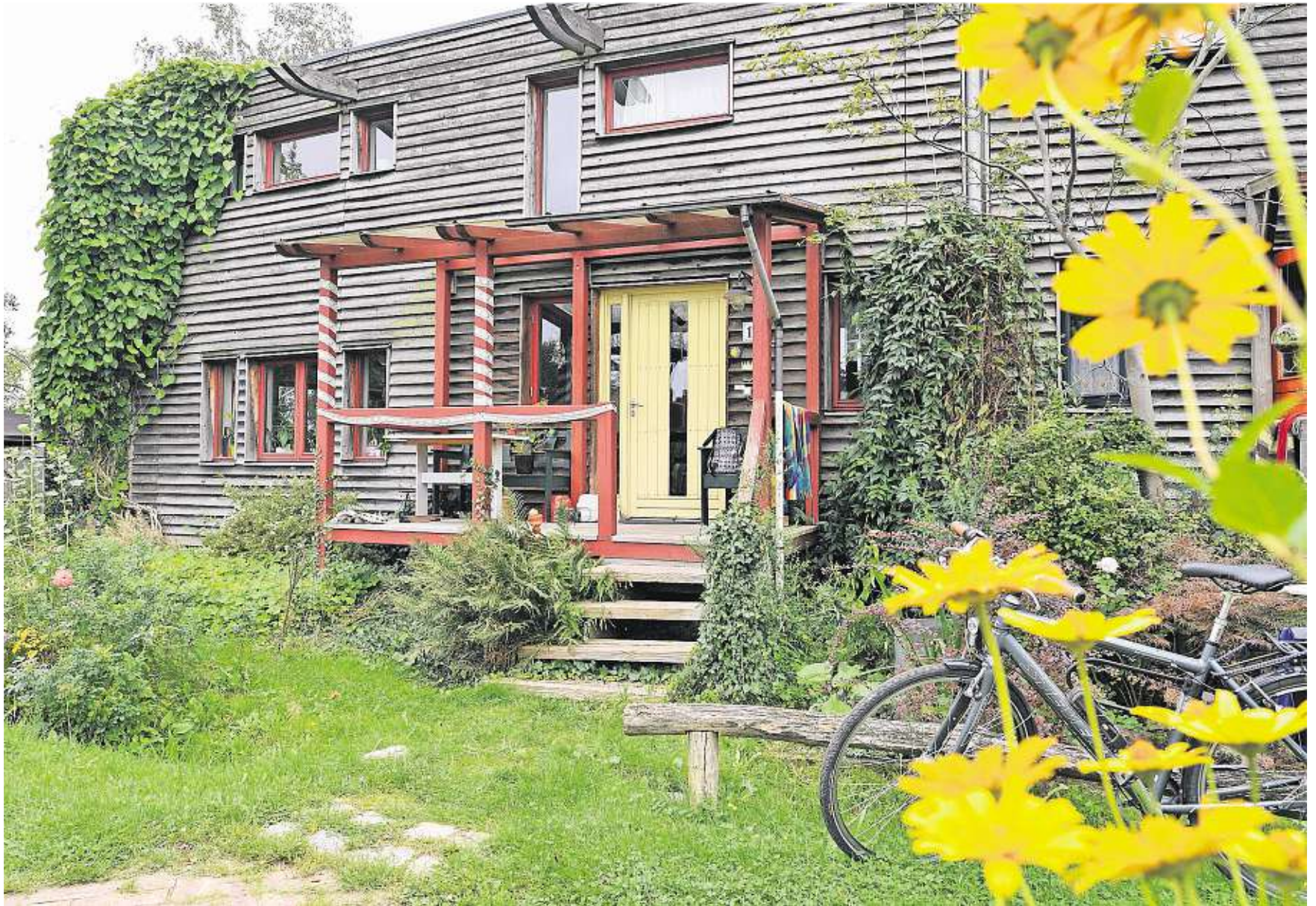
Die Gebäudehülle spielt eine wichtige Rolle bei der Klimabilanz eines Hauses – die Fassade kann man ökologisch etwa mit Holz dämmen. FOTO: PATRICK PLEUL/TMN
